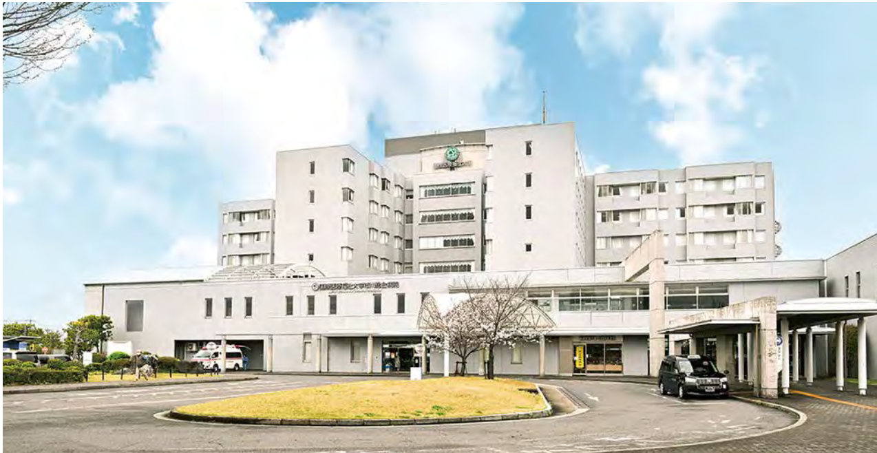
●国際医療福祉大学市川総合病院の外観
